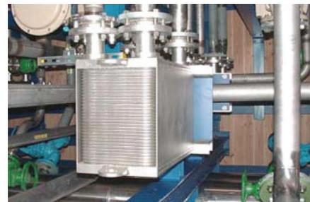
SIGMAWIG ST12 Temperierung des chemischen Reaktors Thermo-Öl / Ethylenglykol
